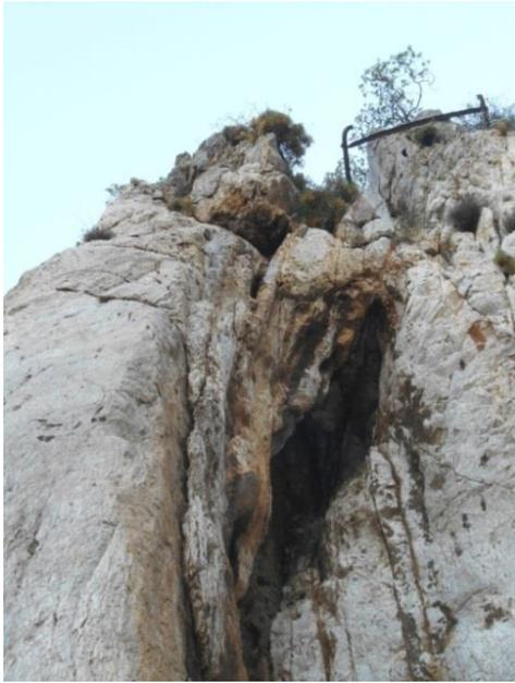
Figura 8: Versante Ovest (particolare): “ancoraggio” masso in condizioni di precario equilibrio.
