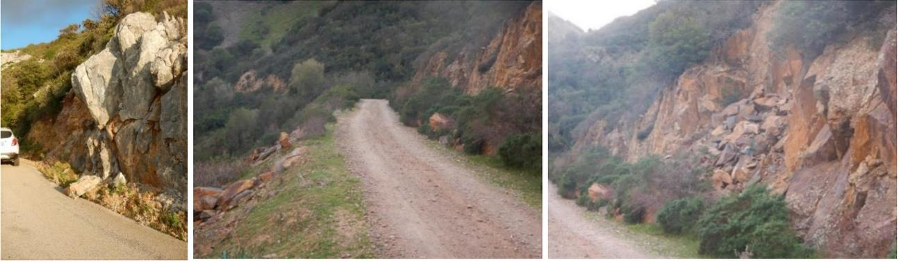
Figura 26: Fenomeni di franamento a monte e a valle nello sviluppo a mezza costa dell'itinerario minerario Buggerru-Fluminimaggiore.
