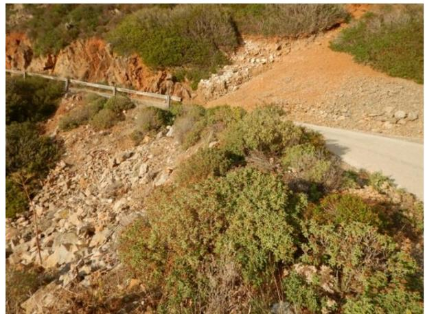
Figura 33: Itinerario minerario Buggerru-Fluminimaggiore, a monte di Buggerru, con evidente fenomeno di franamento di materiale di pezzatura varia, a valle e a monte del percorso stradale
