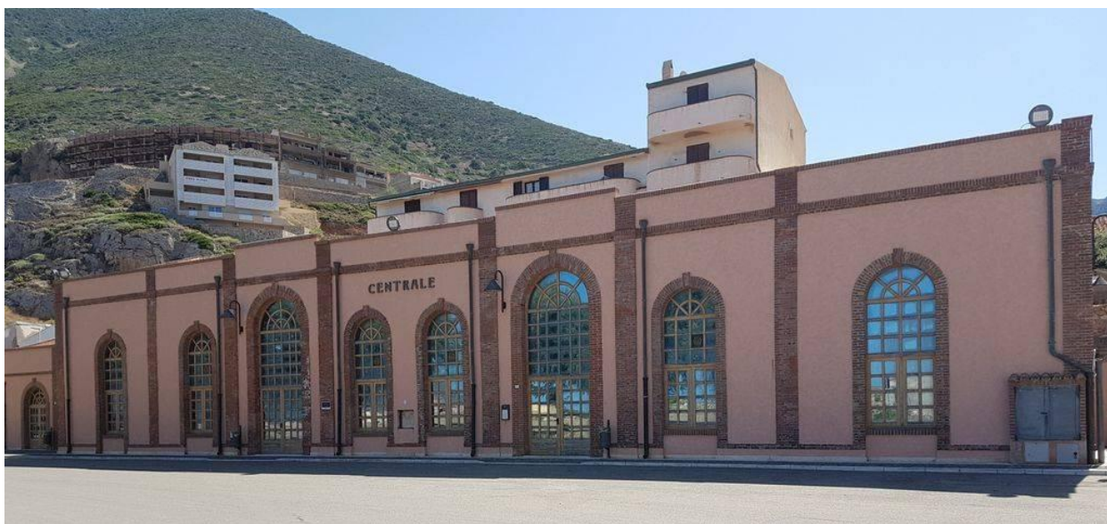
Ex Centrale elettrica
