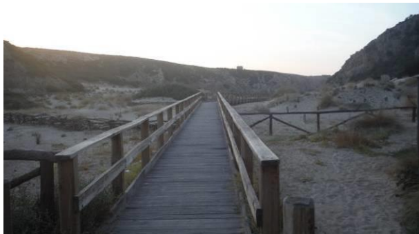
Accesso pedonale (ID 1)
